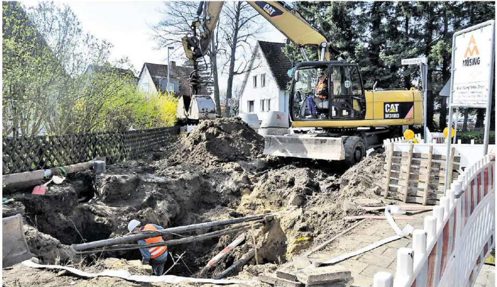
Bevor die Fimbergstraße umfangreich erneuert wird, lassen die Stadtwerke im südlichen Abschnitt der Peiner Straße die Kanäle erneuern.
