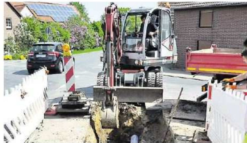
In Bolzum haben die Stadtwerke Sehnde erst 2016 Trinkwasserleitungen erneuert.
