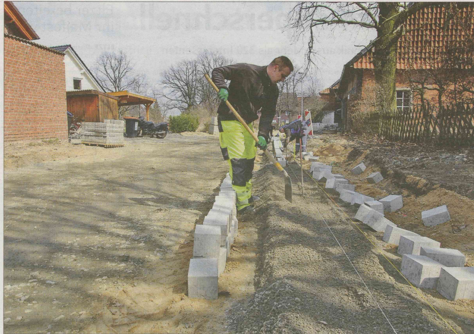
Die Kutscherstraße wird in Schuss gebracht: Mirko Reh und seine Kollegen von dem Subunternehmen Bode setzen Randsteine.
