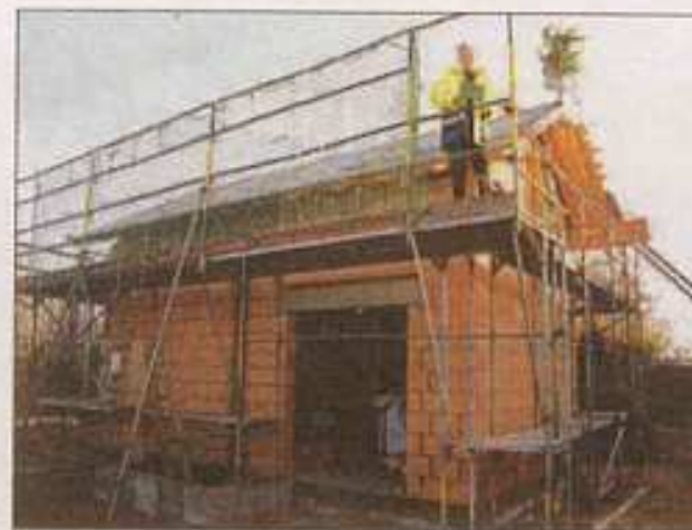
Richtfest nach nur vier Monaten Bauzeit: Frank Jankowski-Zumbrink, Geschäftsführer der Stadtwerke, hält eine Ansprache auf dem neuen Dolgener Pumpwerk. Dettmer
